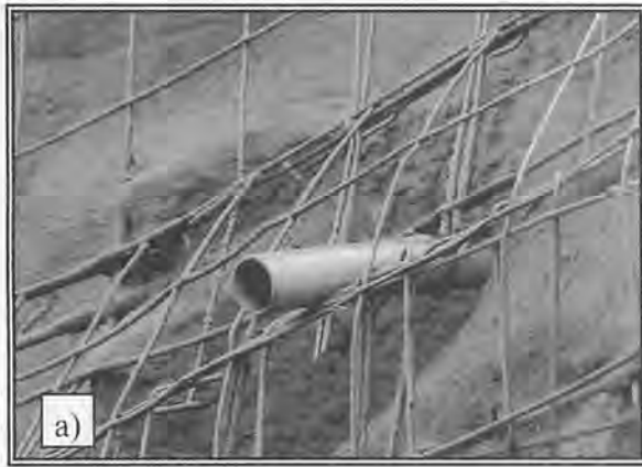
Rajah 4: Bukti ketidakmahiran pekerja yang melaksanakan kerja-kerja pembinaan struktur perlindungan cerun. a) Paip PVC tersebut dibiarkan dalam keadaan tergantung dan bahagian pangkalnya tersumbat akibat semburan konkrit itu sendiri. b) Paip sesalur yang dipenuhi dengan semburan konkrit.
