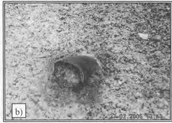
Rajah 4: Bukti ketidakmahiran pekerja yang melaksanakan kerja-kerja pembinaan struktur perlindungan cerun. a) Paip PVC tersebut dibiarkan dalam keadaan tergantung dan bahagian pangkalnya tersumbat akibat semburan konkrit itu sendiri. b) Paip sesalur yang dipenuhi dengan semburan konkrit.
