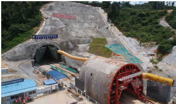
Rajah 2: Pembinaan terowong Kuantan sepanjang 2.86 km oleh Syarikat China Communications Construction Sdn Bhd (CCC) untuk projek Laluan Rel Pantai Timur (ECRL). Sumber: Foto Arkib NSTP.
