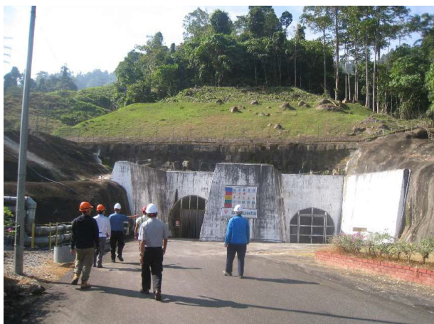
Rajah 1: Terowong Janakuasa Hidroelektrik TNB Pergau, Jeli, Kelantan. Sumber: Mohd Hariri Arifin.
