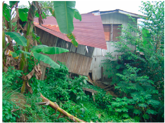
Rajah 7: Terdapatnya tanda-tanda pergerakan berulang pada tiang dan pokok pisang (Kg. Kepungit).
