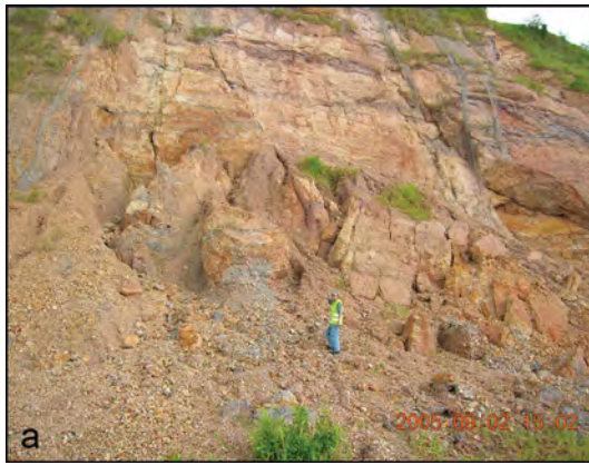
Rajah 3: Tanah runtuh di kawasan kajian. a) Tanah runtuh jenis gelongsoran tanah dan jatuhan batuan di stesen cerapan 12 di km 170.9 melibatkan konglomerat dan tanah berpasir hingga berlodak. b) Tanah runtuh jenis gelongsoran tanah di stesen cerapan 30 yang melibatkan batu pasir berlodak.
