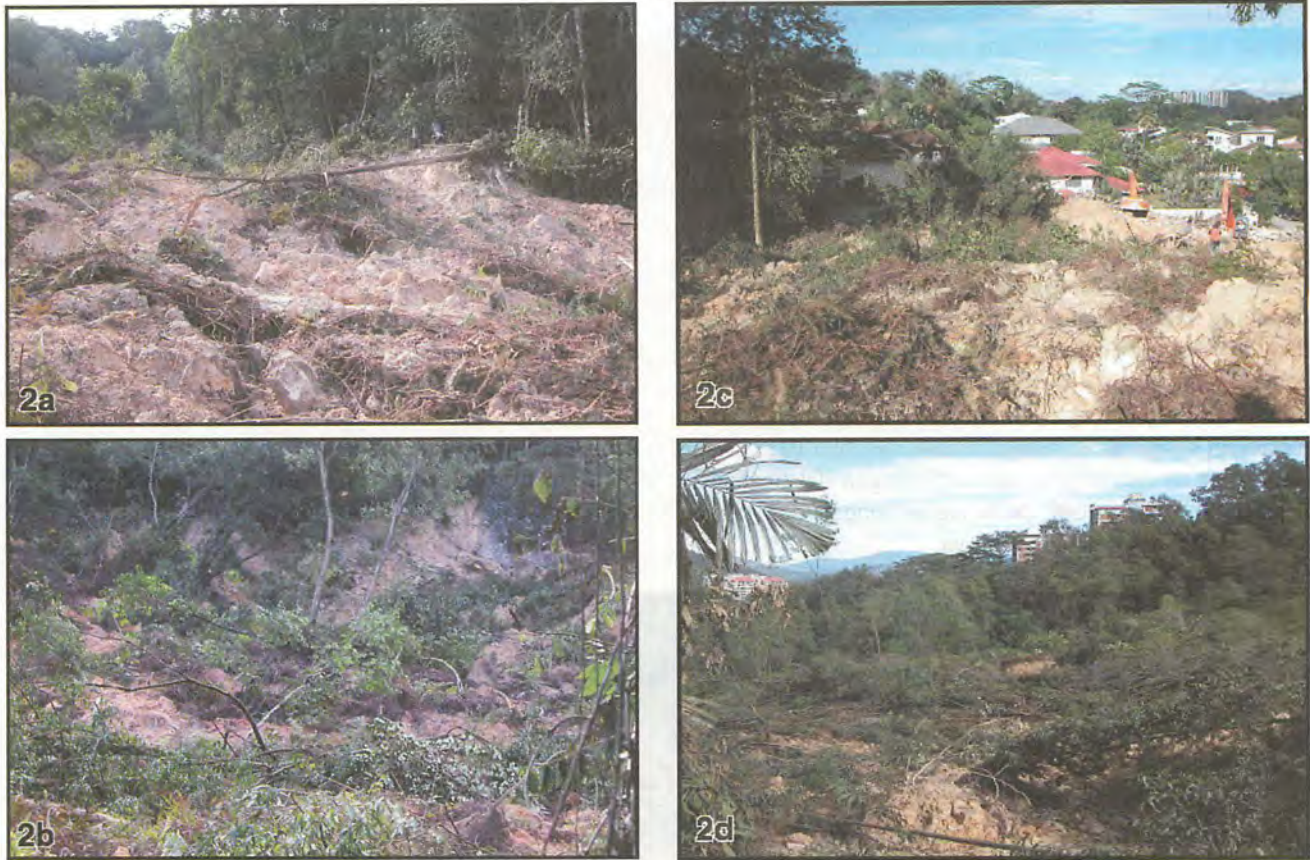
Rajah 2. Beberapa fotograf menunjukkan ciri-ciri lapangan Gelinciran Tanah Taman Hillview. a) Pandangan ke atas – bahan cerun berpasir peroi ditumbuhi dengan belukar dan anak pokok; b) kepala gelinciran – bahagian kanan kelihatan dinding penahan yang membatasi kepala gelinciran, dan bukti gelinciran putaran yang ditunjukkan oleh beberapa pokok dicondongkan ke arah cerun; c) pandangan ke bawah – kerja penggalan dilakukan untuk membersihkan bahan runtuh dan menyelamatkan harta yang tertimbus; d) pandangan sisi – kelihatan dua bangunan Highland Towers iaitu tapak gelinciran tanah tahun 1995 yang mengorbankan 48 nyawa.
