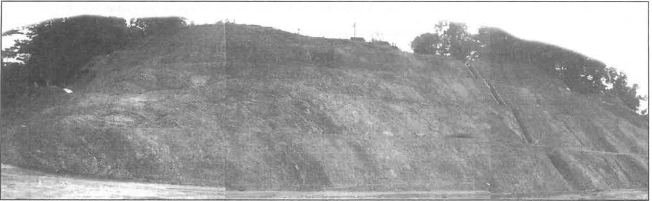
Rajah 1. Pandangan hadapan cerun potongan pada batuan metasedimen terluluhawa serdahana (gred III) hingga tanah baki (gred VI), CH11540-11700 Lebuhraya Baru Pantai, Kuala Lumpur.
