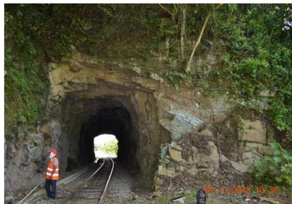
Foto 1: Batu pasir tebal teramalgamasi Formasi Crocker.
