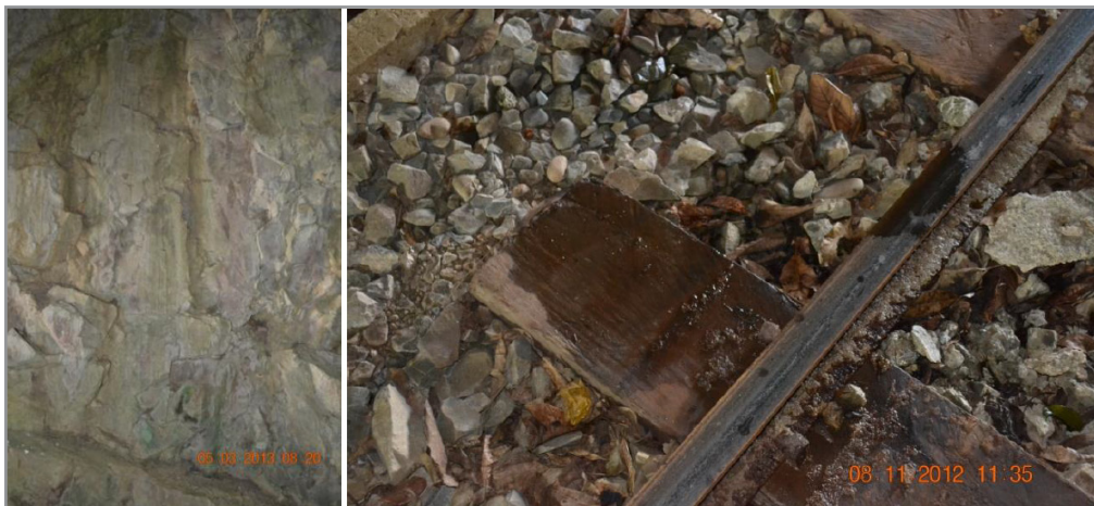
Foto 3: Kesan tirisan air pada dinding (kiri) dan dasar (kanan) terowong.
