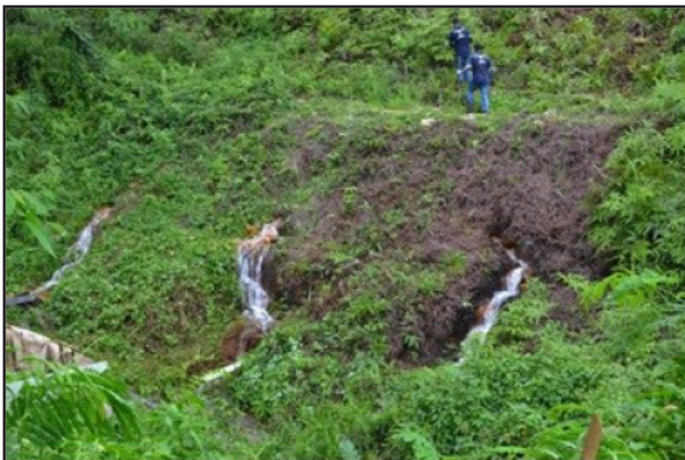
Rajah 13: Tiga mata air yang dicerap pada bahagian kaki cerun tambakan. Kadar pengaliran air yang laju telah menghakis bahan tambakan yang bersaiz halus terutamanya tanah.
