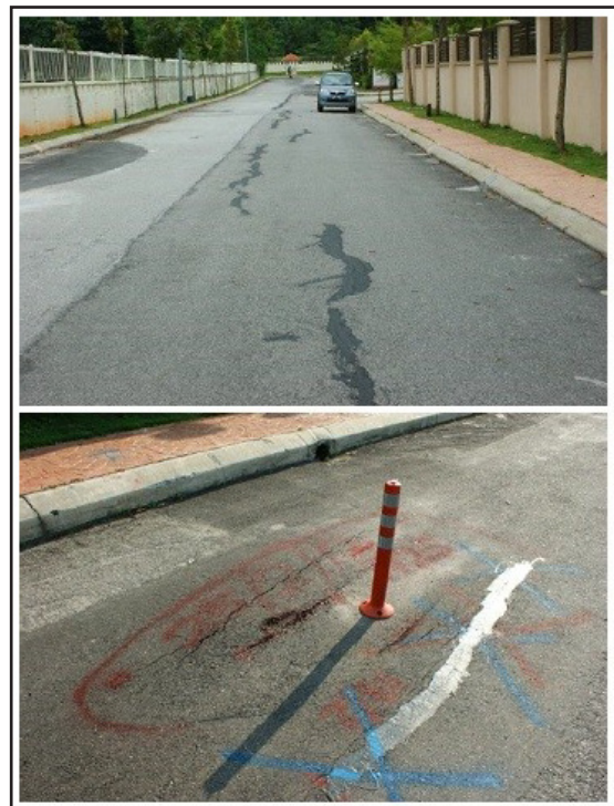
Rajah 10: Retakan tegangan jelas kelihatan pada permukaan Jalan Puteri 9/2 berdasarkan kesan tampalan bitumen untuk membaikinya. Proses pergerakan yang berterusan telah mewujudkan retakan tegangan baru. Proses pengawasan pergerakan yang dilakukan oleh penduduk menunjukkan berlaku pergerakan cerun pada kadar yang berbeza, antara 4mm/minggu hingga 9mm/minggu.
