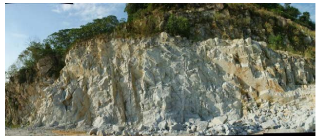
Rajah 4: Blok batuan bersaiz besar yang jatuh daripada muka cerun akibat persilangan antara satah kekar. Blok batuan yang longgar serta tergantung merupakan elemen geobahaya yang perlu diberi perhatian untuk distabilkan.
