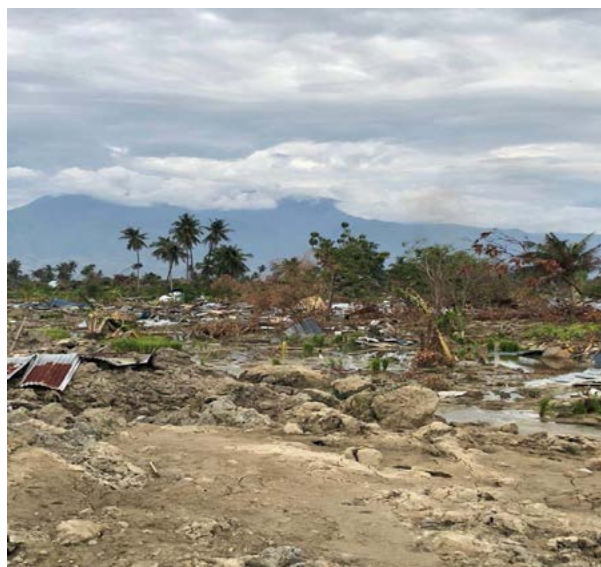
Impak likuifaksi tanah di Petobo.
