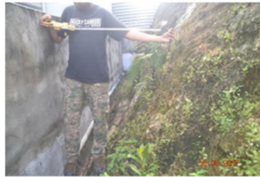
Rajah 5: Jarak antara cerun dengan unit perumahan yang terlalu dekat (kurang 1.0 m) jelas melanggar garis panduan oleh Kementerian Perumahan dan Kerajaan Tempatan, KPKT (2009).
