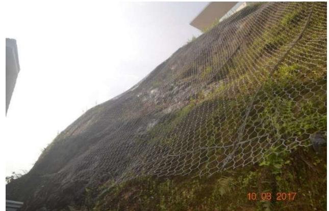
Rajah 3: Cerun batuan yang dikaji berkecuraman 70° dan tidak mempunyai teres. Cerun ber ketinggian 15 m dan mempunyai sedikit litupan tumbuhan. Jelas kelihatan sistem jaringan wayar yang digunakan sebagai sistem sokongan untuk cerun ini. Keadaan wayar yang longgar kerana tidak disokong dengan sauh yang cukup menghadkan keupayaannya untuk menstabilkan cerun ini.
